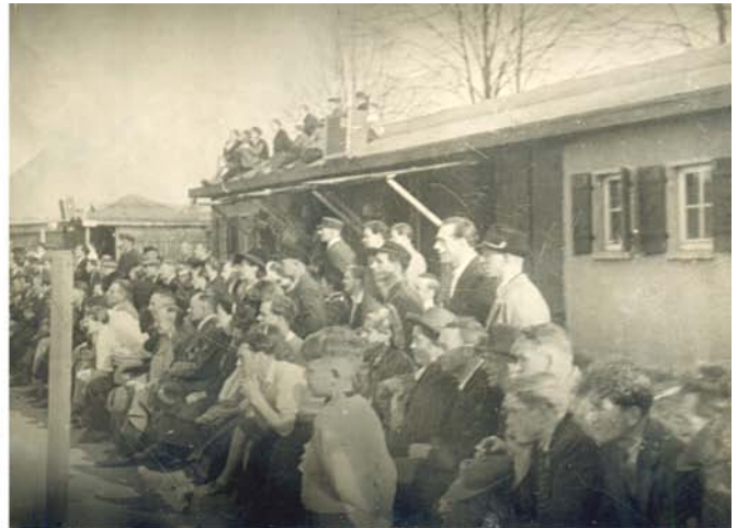
Funktionsgebäude auf dem alten Sportplatz mit Zuschauern im Vordergrund.
