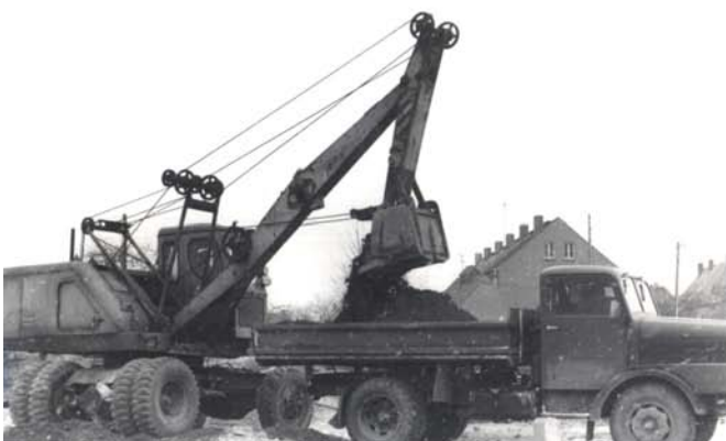
... man führte Erdarbeiten aus.
