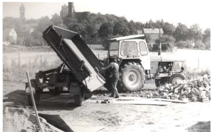
Baumaterial musste angefahren und ...
