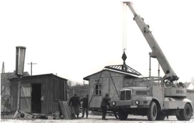
Baufreiheit musste geschaffen werden.
