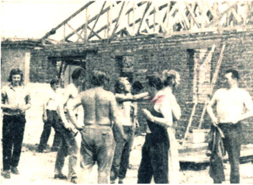
Bereits im vergangenen Jahr beteiligten sich viele Stolpener in VMI-Einsätzen beim Bau des neuen Sozialgebäudes auf dem Sportplatz. Auch 1975 setzen sie alles daran, damit das Gebäude am 7. Oktober, zum Jahrestag unserer Republik, übergeben werden kann. Foto: Manfred Beier, Kulturbund-Fotogruppe Stolpen
