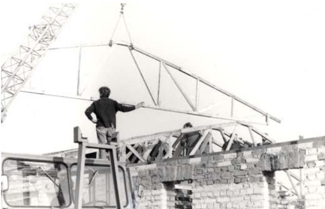
Die Dachkonstruktion wird mit einem Kran ...
